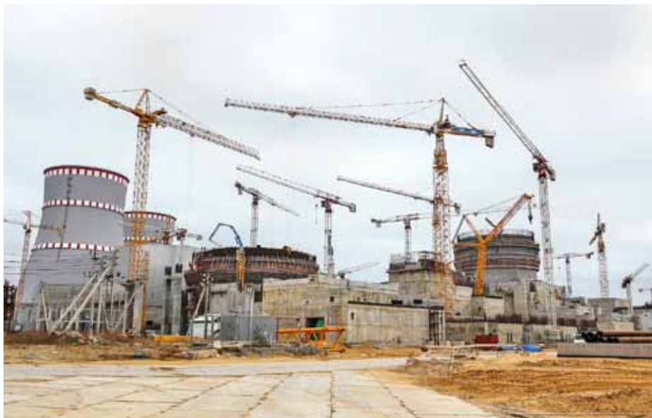
Stavební ruch v Leningradské JE-2 v roce 2015
