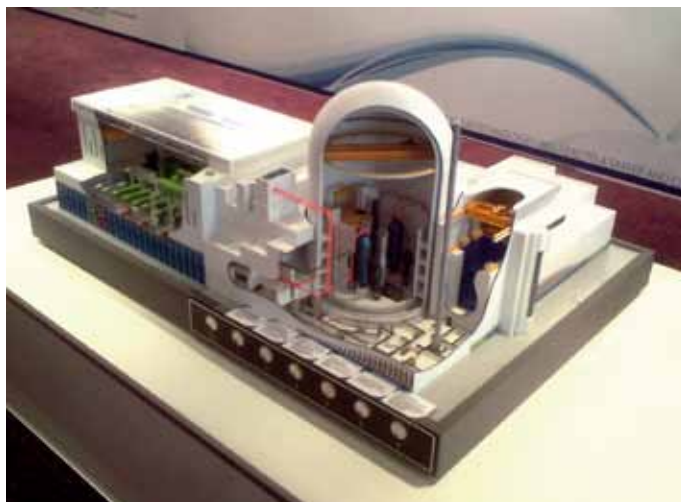
Model reaktoru APR+, který KHNP nabízí pro Temelín - jde o vylepšený typ odvozený korejského jaderného reaktoru OPR1000
